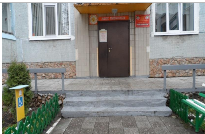
Вход в здание
